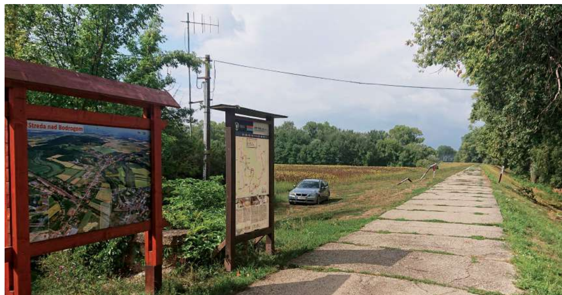
Hrádza rieky Bodrog v Strede nad Bodrogom
