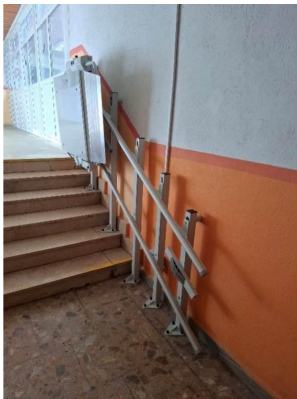
Šikmé schodiskové plošiny v prístavbe
