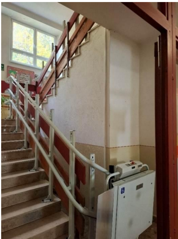
Šikmé schodiskové plošiny v prístavbe
