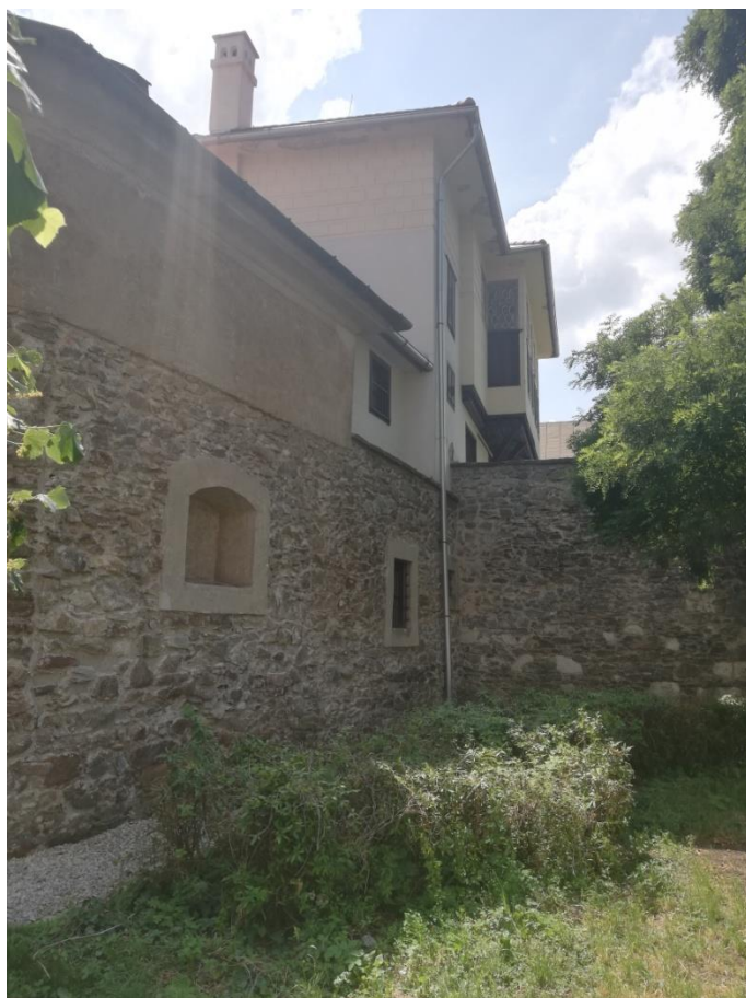
• Východná fasáda Rodošta.
