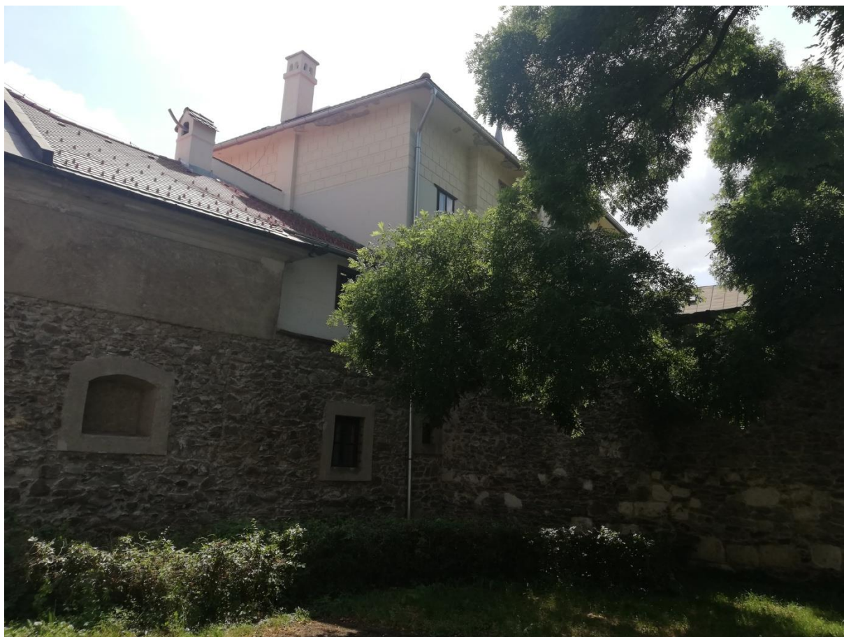
• Východná fasáda Rodošta.
