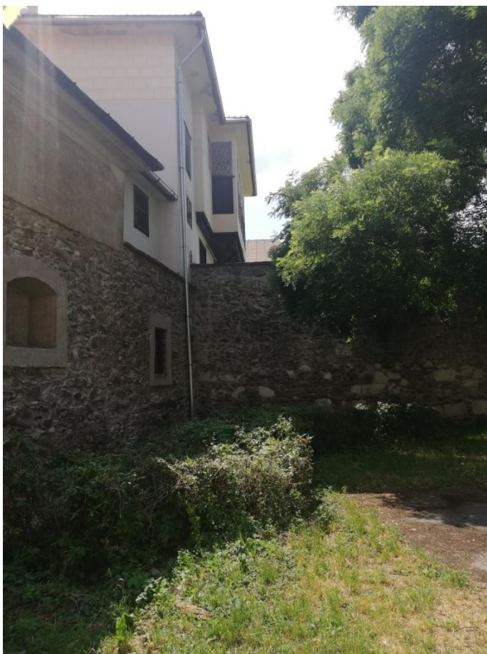
• Východná fasáda Rodošta.
