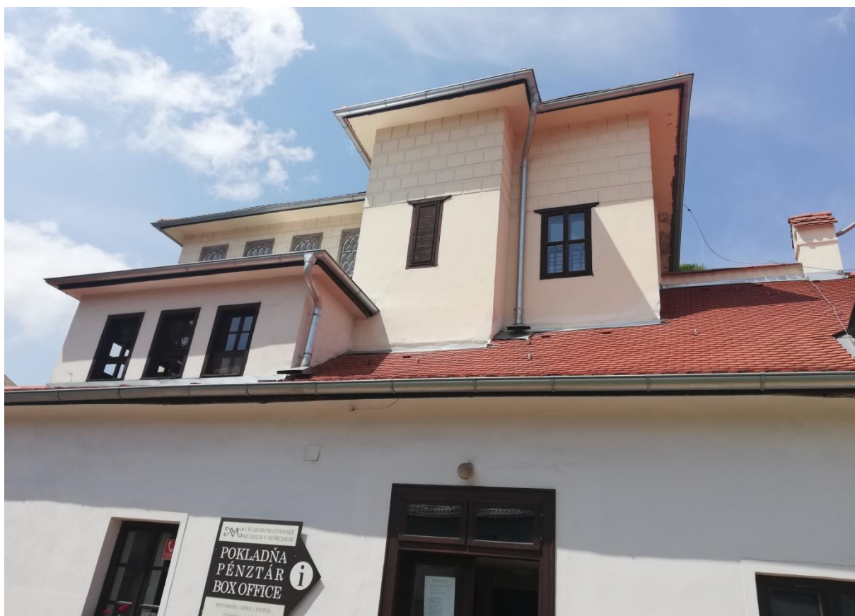
• Južné fasády nadzemných nadstavieb časti mestského opevnenia tzv. Rodošto, ktoré prestupujú strechou.
