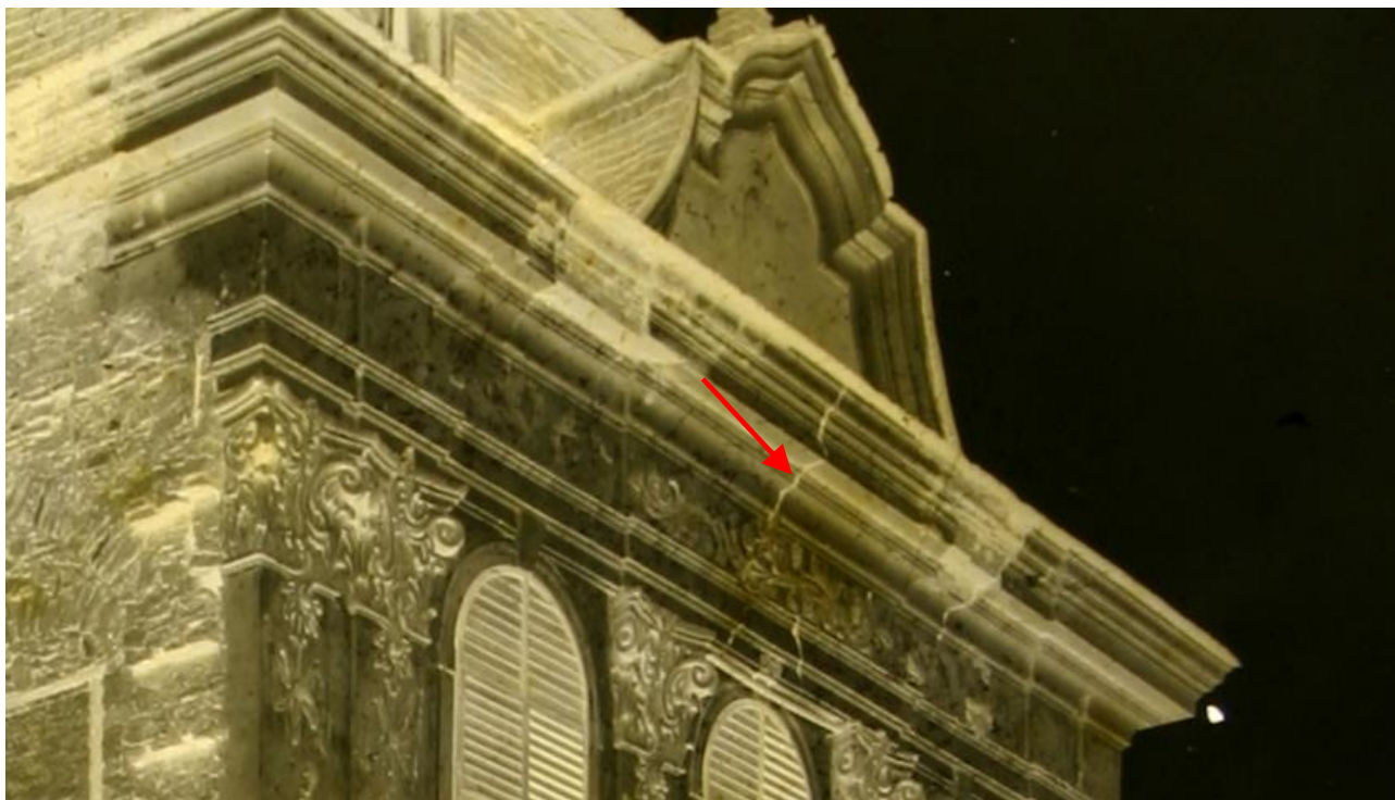
Obr.06 Trhlina na starom negative (ešte pred dostavaním bočných krídel)
