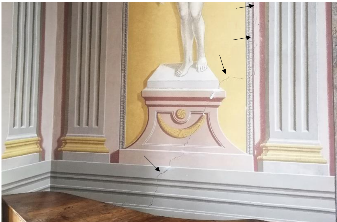
Obr.02 Šikmá a vertikálna trhlina vo výplňovom murive otvoru
