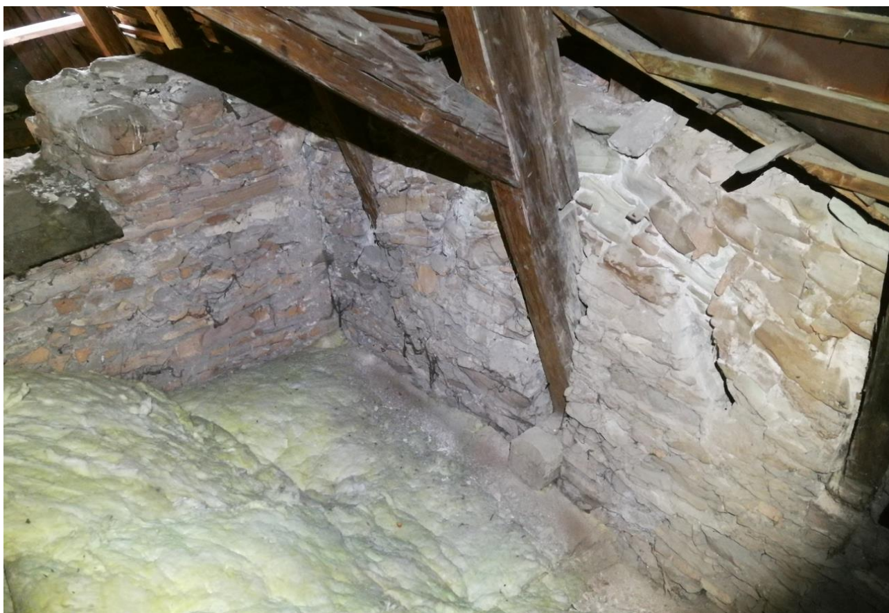
Obr.08 Krokvy, ktoré sú prakticky priamo „zapichnuté“ do obvodového muriva bez zachytenia horizontálnej sily väzným trámom
