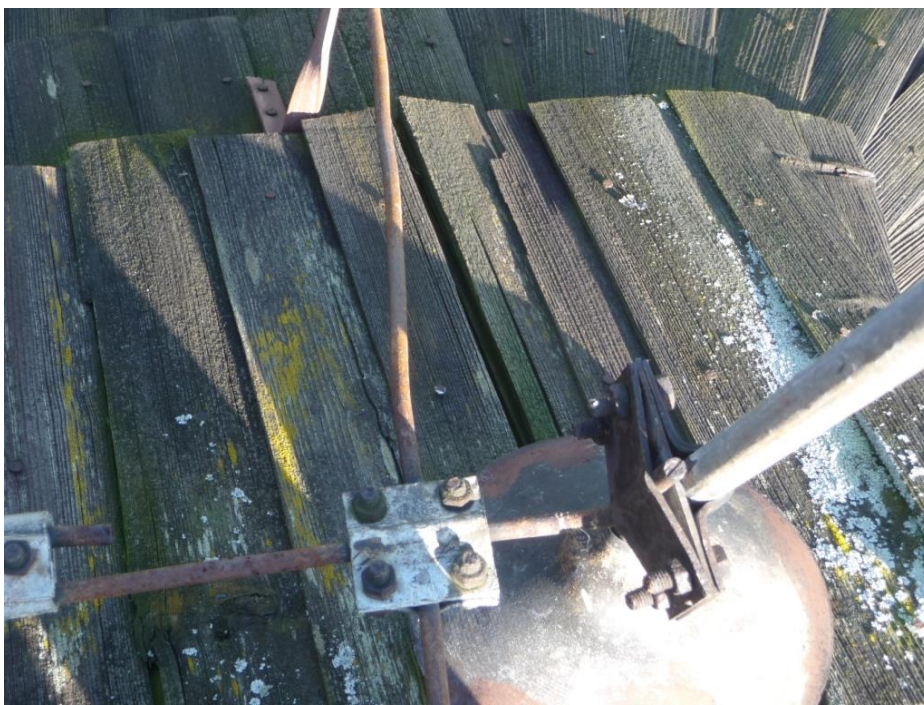
Obr. 02 poškodené drevené šindle, napadnuté machom , blezkozvod
