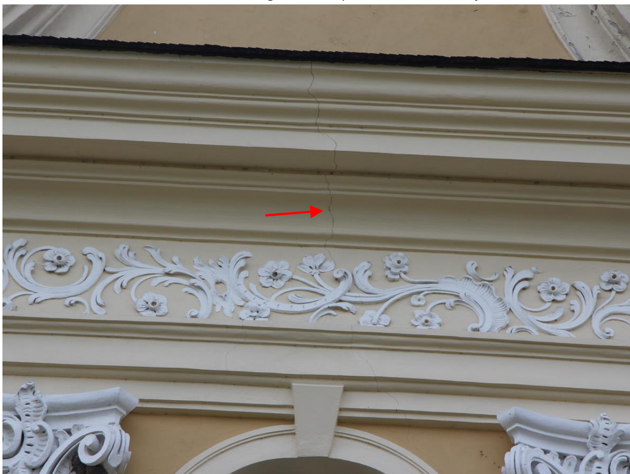
Obr.07 Trhlina vykreslená na novej fasáde – pravdepodobne sa jej sanácii nevenovala pozornosť
