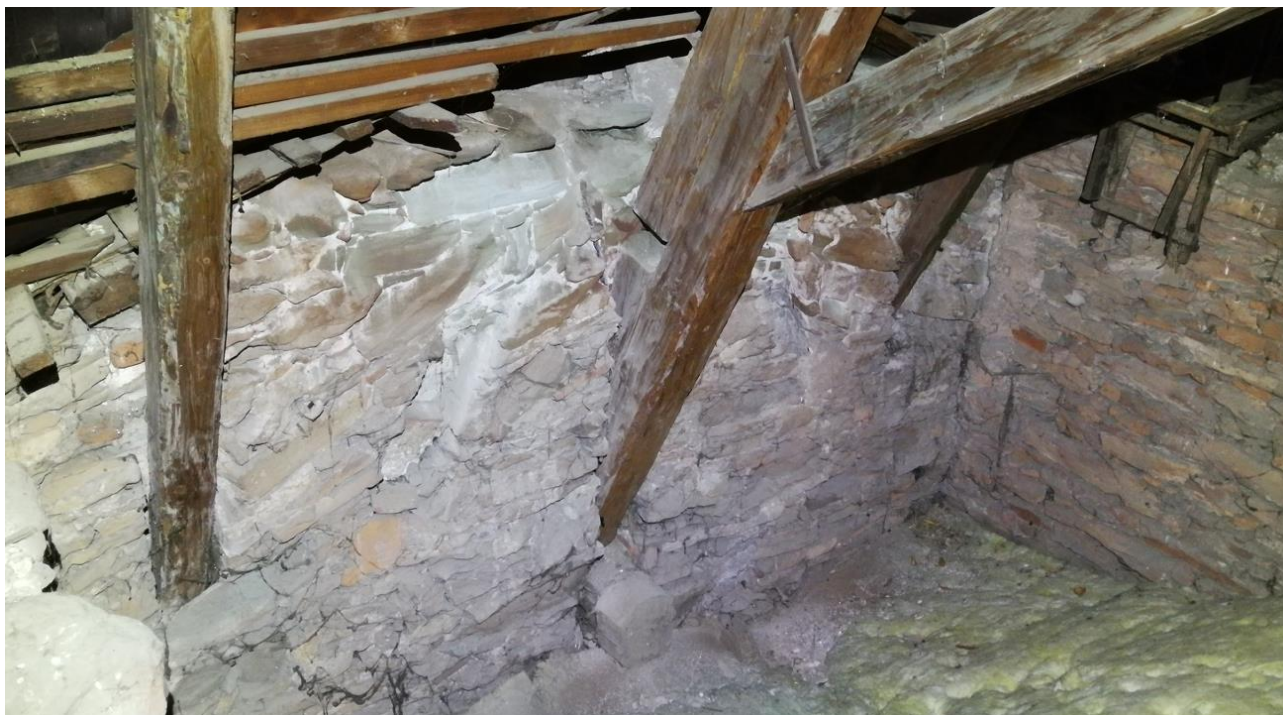
Obr.09 Krokvy, ktoré sú prakticky priamo „zapichnuté“ do obvodového muriva bez zachytenia horizontálnej sily väzným trámom
