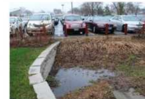
Regnbød som fanger opp avrenning fra parkeringsplass ved University of Minnesota, St. Paul, USA. Tynnere infiltrerer ned til grunnen mens forurensningen forblir i filtermediet.
